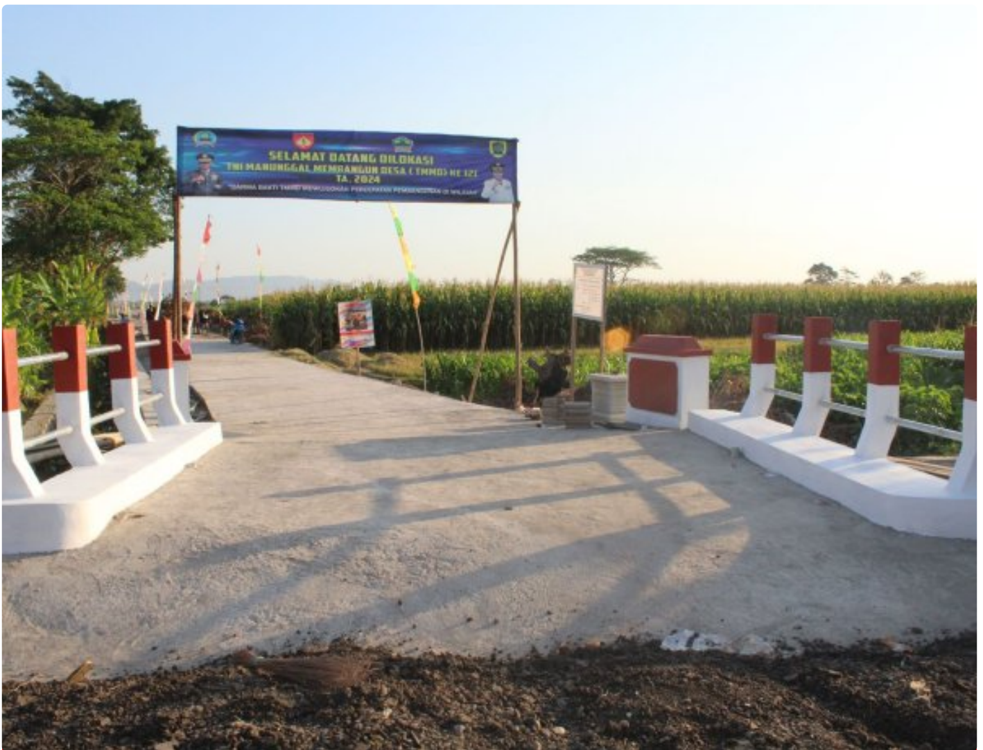
Dandim Klaten Berharap Warga Merawat Jembatan TMMD
